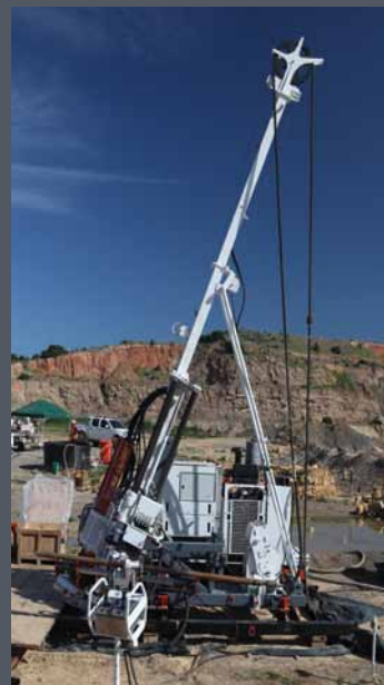
Equipos para extracción de testigos en superficie
